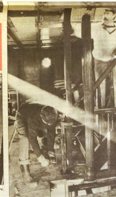
s/s Kastelholms inredning av ädelträ rivs ut innan skärbrännarna tar vid. Fartyget byggdes 1929.
