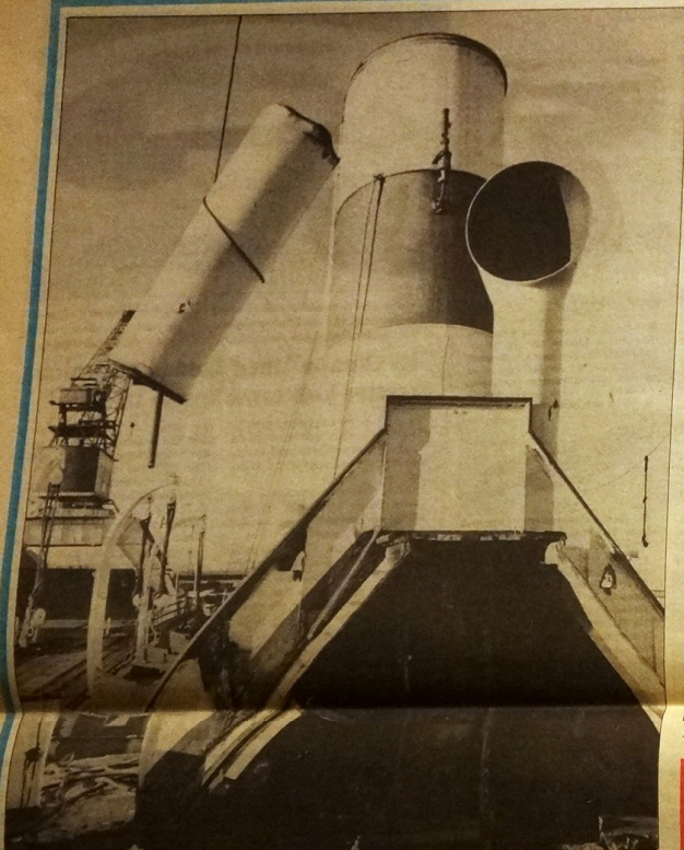
En av ventilerna har skurits loss från s/s Kastelholm och hissas iland med lyftkran.
